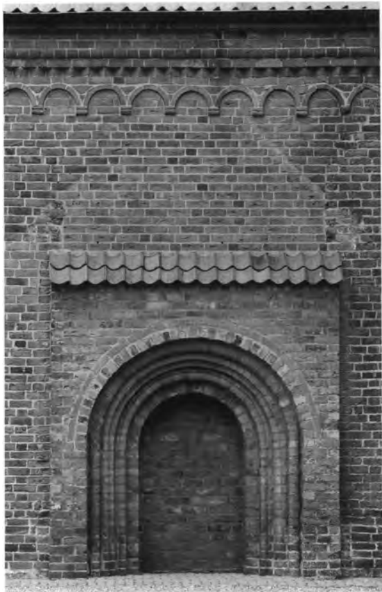
Fig. 13. Skibets syddør (s. 3354). NE fot. 1994. - South door of the nave.
