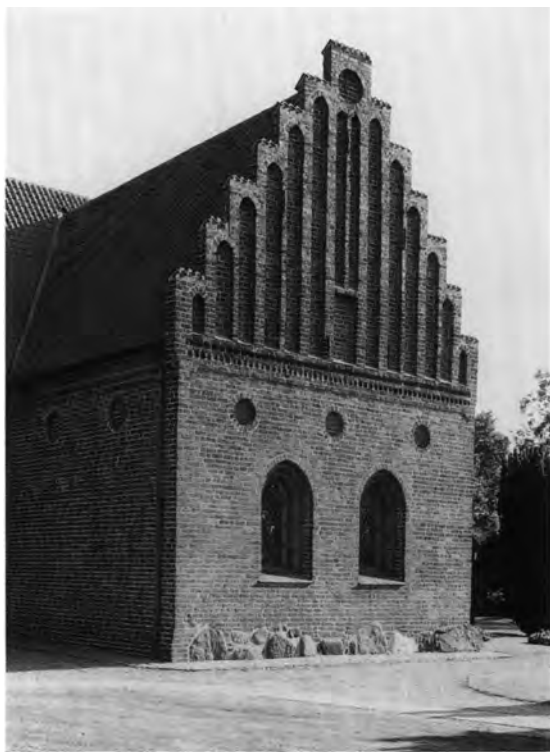
Fig. 18. Kapellets gavl mod syd (s. 3360). LL fot. 1981. - The chapel's south gable.
