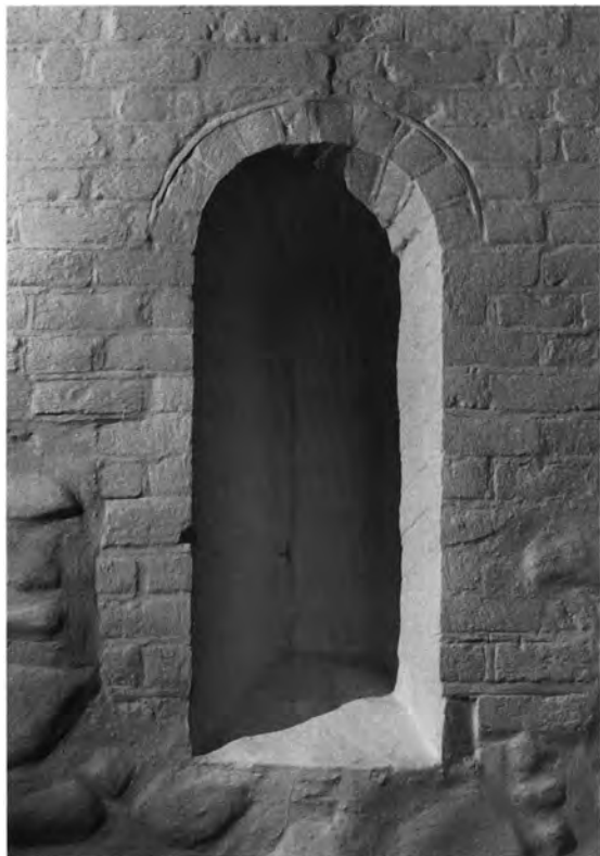
Fig. 14. Vindue i korets nordvæg (s. 3355). NE fot. 1995. - Window in the chancel's north wall.
